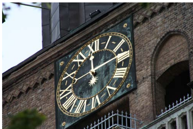
Odnowione tarcze zegara wieżowego.
